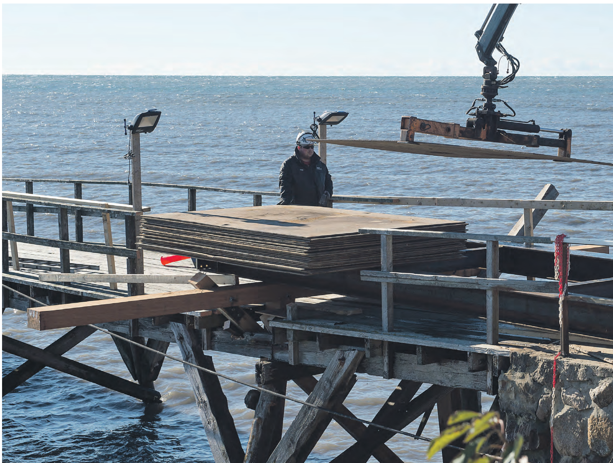
De to nye træstolper har i nat modstået trykket fra 34 tons jernplader. Nu starter broarbejdet for alvor i Arnager Havn. Foto: Allan Rieck
