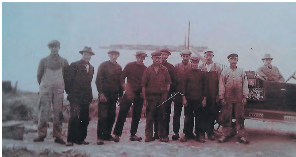
Broen til Arnager Bådehavn har været igennem flere totalrenovationer siden opførelsen i 1884. Her er brosjakket fra 1930'erne. Foto fra Bådehavnens hjemmeside.
