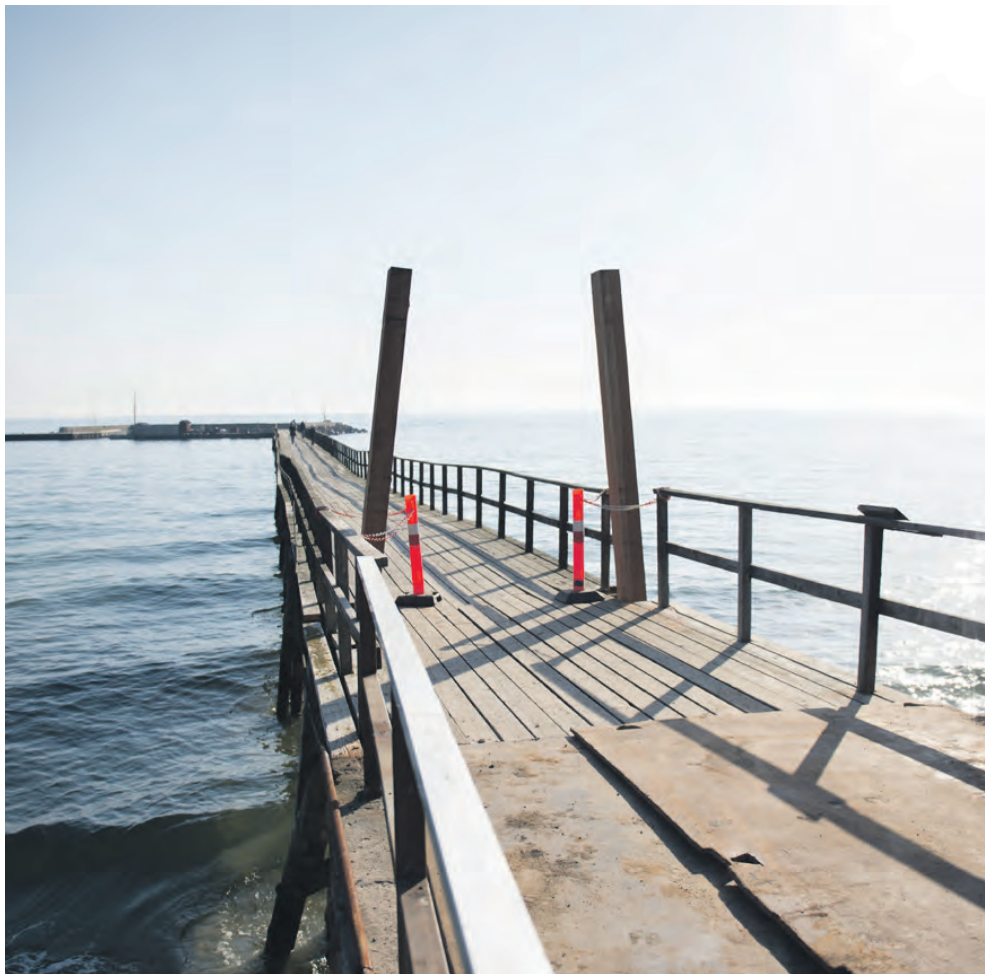
Mandag blev de to pæle banket i havbunden tre fag ude på Arnager Bro. I morgen, torsdag, skal de stå prøven, når omkring 100 tons jern lægges på. Foto: Berit Hvassum
